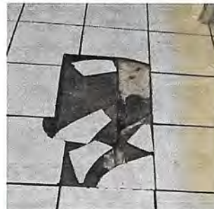
Foto 2: Demolición e instalación de 100 metros de piso
