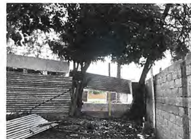
Foto 4: Se realizaran 80 metros de cernido de Monocapa en el muro perimetral de 40 metros de ambos lados
