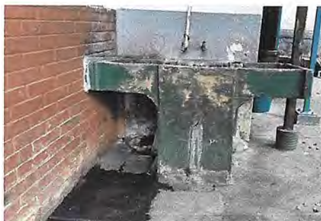
Foto 5: Sustitucion de pileta de concreto.
