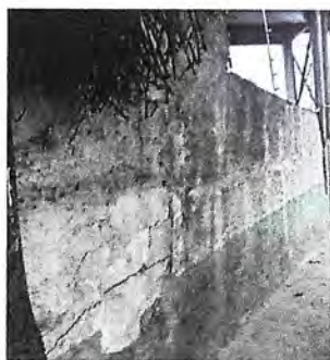
Foto 3: 40.50 metros de levantado de muro perimetral dañado , cernido y pintado
