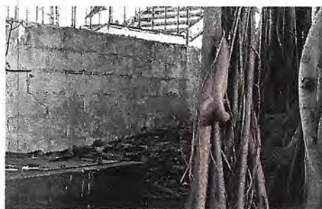
Foto 4: 40.5 metros de levantado de muro perimetral dañado , cernido y pintado
