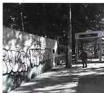
Foto 2: 40.5 metros de levantado de muro perimetral dañado , cernido y pintado
