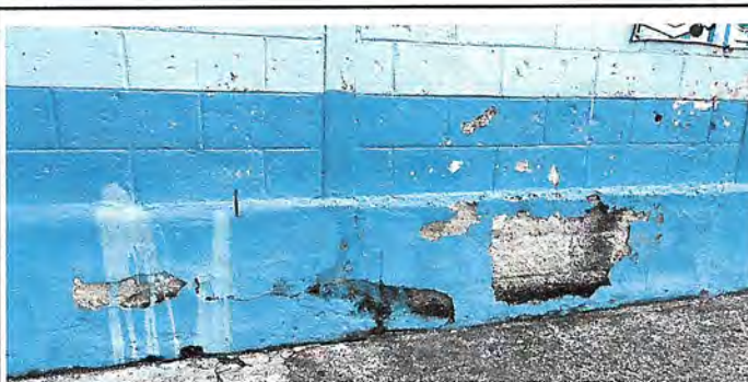
Foto 5: Cerco o muro perimetral
