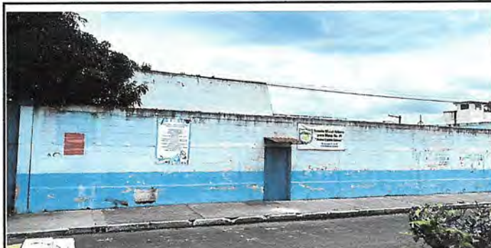
Foto 6: Pintura en muros interiores y exteriores. Aplicación de 526.50 m2 incluye 80cm de zocalo
