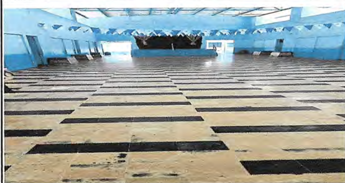
Foto 2: Instalación de 218.00 m2 de piso cerámico sobre piso existente en mal estado
