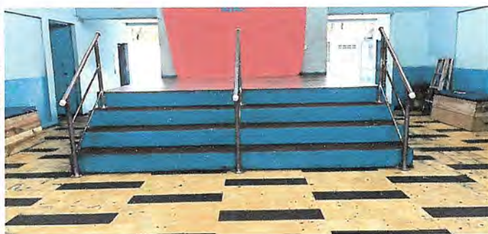
Foto 3: Mantenimiento de barandas. Fijación y aplicación de pintura sobre barana de metal.
