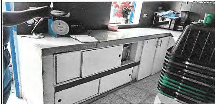
Foto 4: Reparación o sustitución de área de cocina
