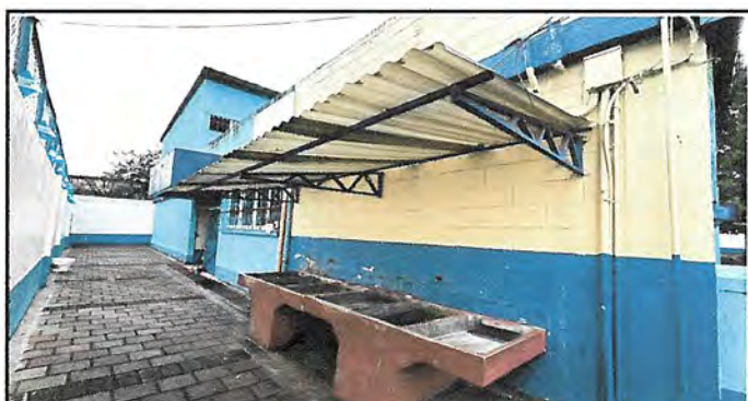
Foto 4: Techado (estructura portante de metal de pasillo hacia las pilas)
