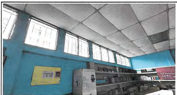
Foto 6: Cambio de ventanas de aluminio por PVC
