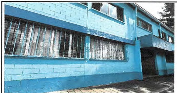
Foto 5: Techado (estructura portante de metal de pasiillo de pilas hacia salida de alumnas)
