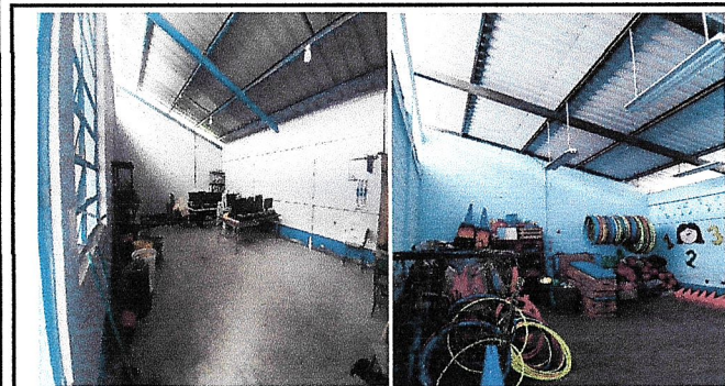
Foto 3: PINTURA DE EXTERIORES E INTERIORES DE AULAS DE CLASES DE PARVULOS Y PRIMARIA, COCINA, BIBLIOTECA Y DE COMPUTACION.
