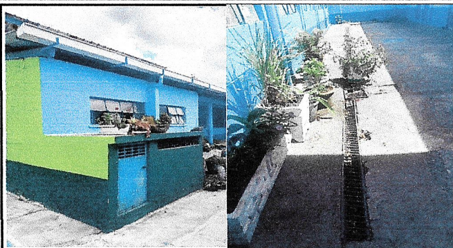
Foto 7: REPAACION Y RESANADA DE CUNETA Y REJILLA EN MAL ESTADO Y ADECUACION DE BASE PARA TINACO DE LA COCINA.
