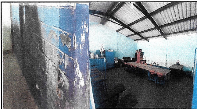
Foto 8: REPACION DE REPELLO Y CERNIDO DE PAREDES EN LAS AULAS DE EDUCACION FISICA, PRIMERO, DIRECCION.
