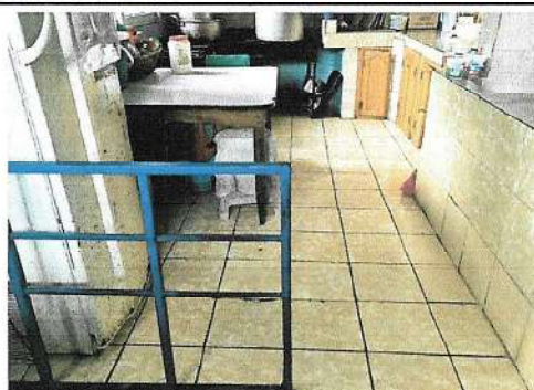
Foto 2: SUSTITUCION DE PISO EN AREA DE COCINA 01.
