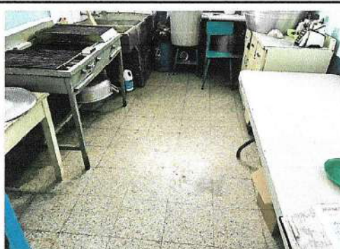
Foto 4: SUSTITUCION DE PISO EN COCINA 02, SUSTITUCION Y REUBICACION DE PILA, INSTALACION DE CAMPANA EXTRACTORA CON DUCTO DE CHIMINEA EN AREA DE ESTUFA.
