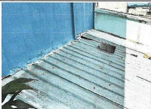
Foto 1: SUSTITUCION DE LAMINA EN AREA DE BODEGA
