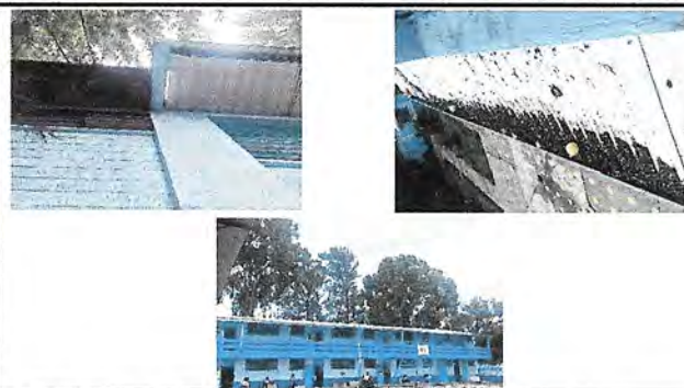
Foto1: 3. Impermeabilización de losa. (Reparación de losa 6to grado) 7. Canales y badas de agua pluvial. (Limpieza de canaletas 2do nivel, aulas y biblioteca.)
