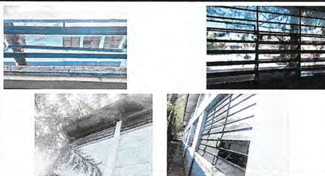
Foto 3: 5. Ventanas. (Sustitución de ventanas de aulas, sanitarios y dirección.)
