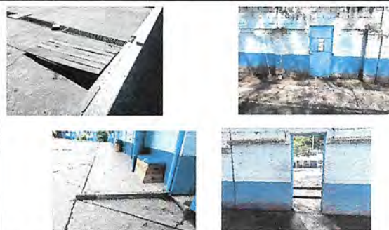
Foto 6: 16 Losa de patio. (Elaboración de 3 rampas de acceso, 1 de ingreso al establecimiento y 2 de acceso a corredores.)
