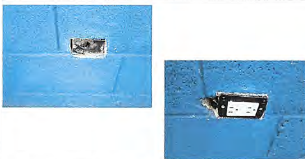
Foto 5: 17 Reparación de sistema eléctrico. (Cambio y reparación de toma corrientes de aulas, salón de usos múltiples y biblioteca)
