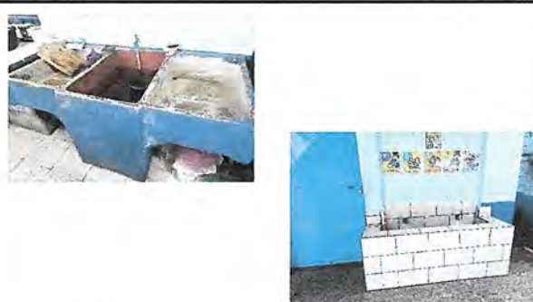
Foto 4: 13 Reparación o sustitución de azulejo. (En lava manos de planta baja y pila de la cocina.)
