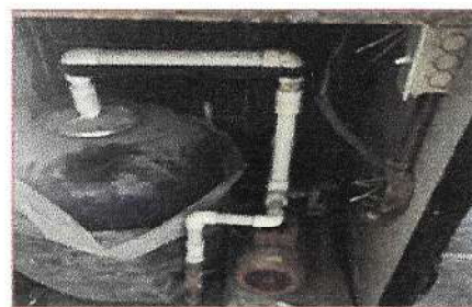
Foto 18: Instalación eléctrica de la bomba
