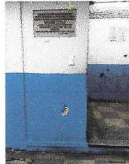
Foto 8: Cambio de repello 3 paredes REPARACION DE REPAELLO Y (Sustitucion de repello de todas las paredes . Se eliminara todo el repello existente en las paredes dejando al desnudo el ladrillo, se repellara
