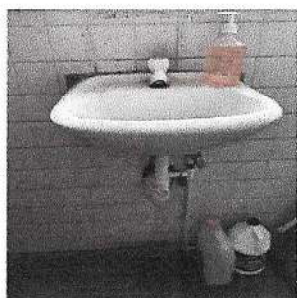
Foto 15: Instalación de lavamanos de la jornada vespertina
