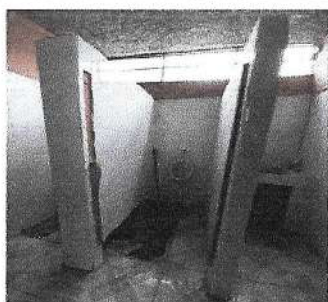
Foto 17: Sustitución de puerta de madera
