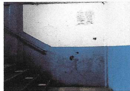
Foto 12: Cambio de repello 3 paredes REPARACION DE REPAELLO Y (Sustitucion de repello de todas las paredes . Se eliminara todo el repello existente en las paredes dejando al desnudo el ladrillo, se repellara
