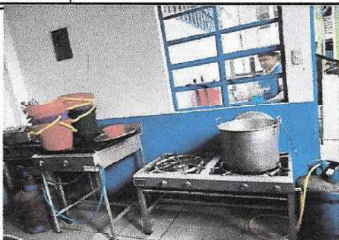
Foto 13: Elaboración de caseta para cilindros de gas con su respectiva tubería.
