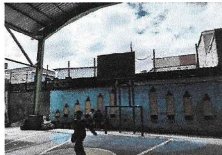
Foto 10: Sustitución de malla perimetral en mal estado de 16 metros de largo * 2.20 metros de alto por estructura metálica con malla desplegada
