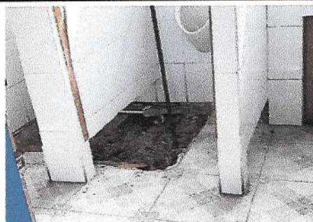
Foto 6: Remoción de piso y extracción de tierra para dejar al descubierto las tuberías originales de drenaje, para posterior mente cambiar todas las tubería que se encuentren por tubería de PVC .
