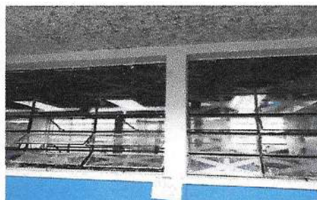
Foto 16: Aplicación únicamente de pintura color azul a estructura de los ventanales de la escuela de 30 ventanales
