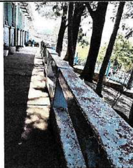
Foto 4: PINTURA GENERAL EN MUROS EXTERIORES.
