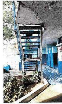
Foto 2: SUSTITUCION DE MODULO DE GRADAS EN MAL ESTADO.
