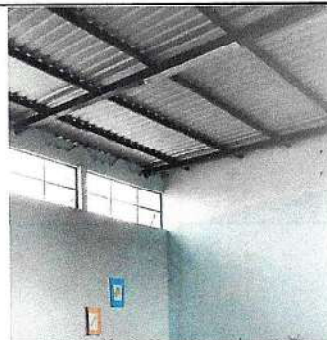
Foto 6: PINTURA GENERAL EN MUROS INTERIORES.
