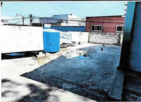
Foto 1: SUSTITUCION DE MEZCLON EN MAL ESTADO Y APLICACION DE NUEVO MEZCLON
