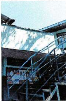
Foto 3: SUSTITUCION DE MODULO DE GRADAS EN MAL ESTADO.
