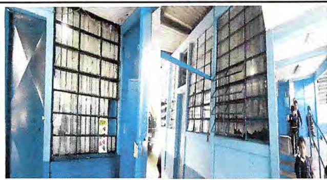
Foto 4: sustitución y modificación de 3 ventanas en mal estado uno con su balcon nueva de ambas direcciones de jornada matutina y vespertina.
