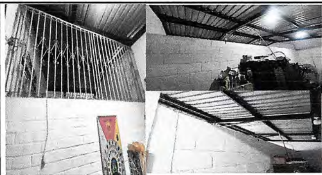
Foto1: Reparación muro central en división central de direcciones y bodega de jornada matutina y vespertina y pintar el nuevo muro de ambas jornadas.
