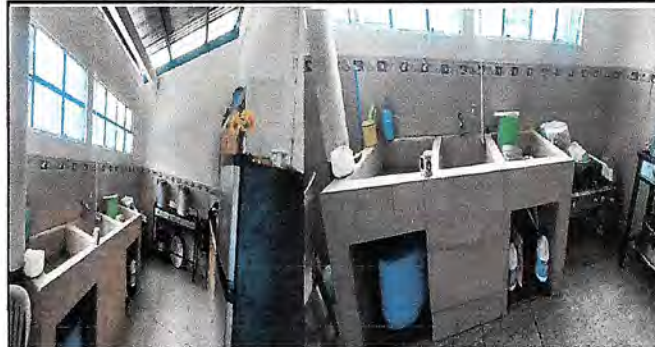
Foto 8: sustitucion de azulejos en mal estado de la pila, pared y de gabinetes por nuevo azulejos.
