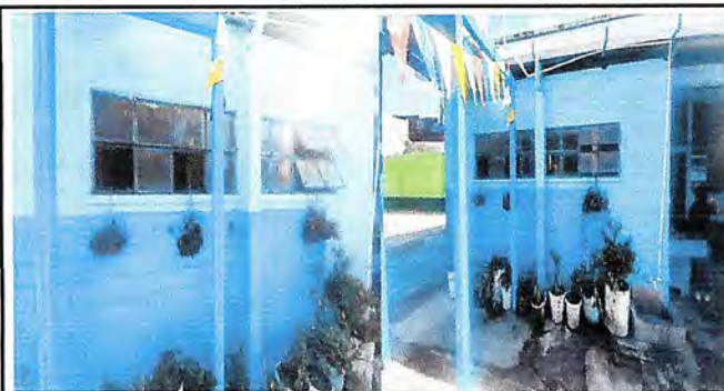
Foto 3: sustitución y modificación de 2 ventanas en mal estado de la cocina con balcones nuevas.
