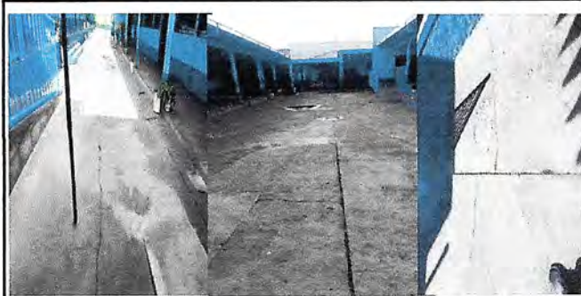
Foto 6: sustitución de losa engrietada y en mal estado en el área de primaria
