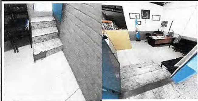
Foto 5: Sustitución de piso en mal estado por nuevos en la dirección jornada matutina.
