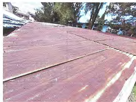
Foto 2: Sustitución de Lámina
