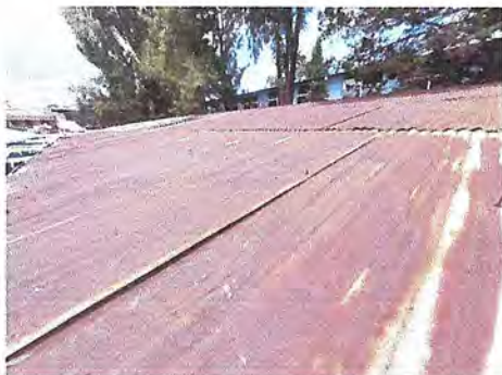
Foto 1: sustitución de Lámina
