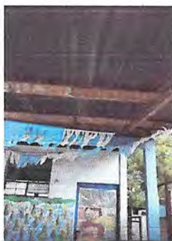
Foto 5: Mantenimiento de estructuras
