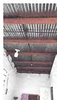
Foto 4: Cambio de parales de madera
