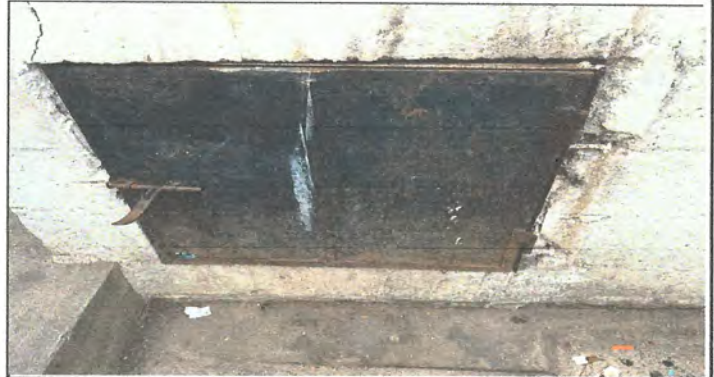
*cambio de puerta de basurero existente ( 0.58 x 0.60)
