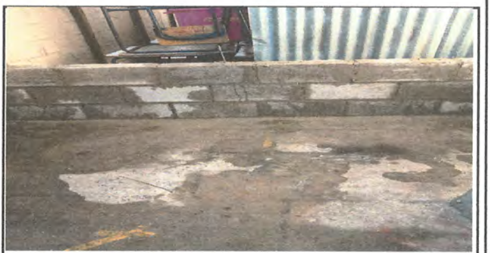
agregar 3 filas de block a muro existente para bodega respetando 6 columnas existente de 0.30 cm de ancho y un altura de 0.65 x 8.20 de largo
