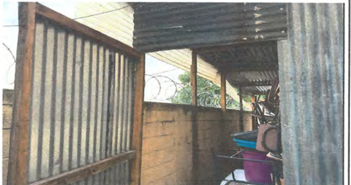
agregar 3 filas de block a muro existente para bodega respetando 6 columnas existente de 0.30 cm de ancho y un altura de 0.65 x 8.20 de largo
