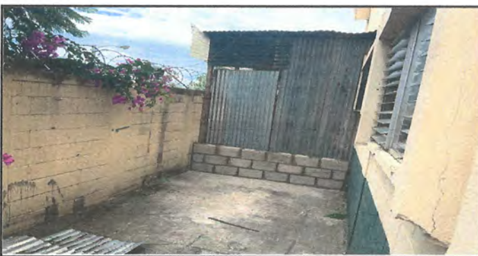
apertura de vano para puerta de ingreso a bodega (1 x 203) tallado ser hara refuerzo en el marco de la puerta
