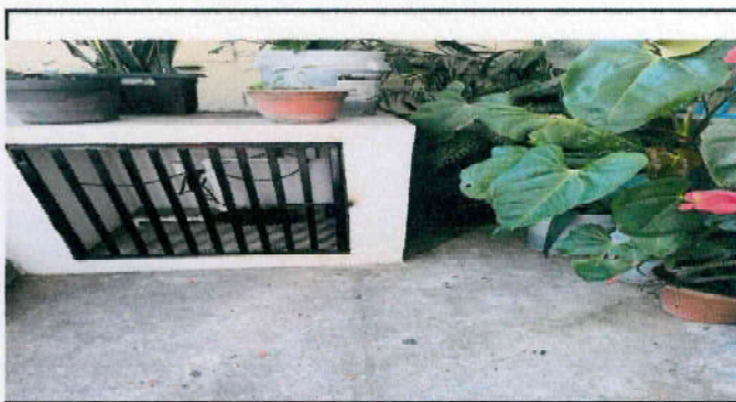
cambio de puerta de caseta de cisterna de hierro con pasador y armallas de 1.25 x 1.05
