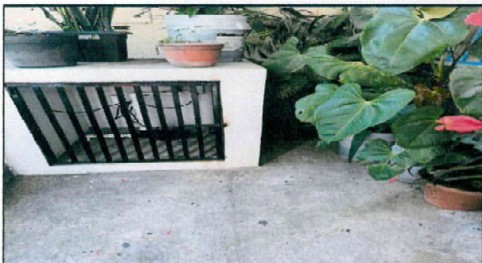
sustitución de bomba de agua e instalación de bomba marca sta rite de 3/4 y hidroneumatico de 35 galones
