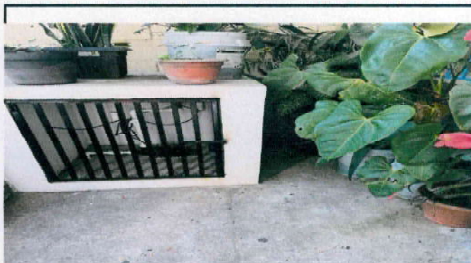
instalación de hidroneumatico de 35 galones
