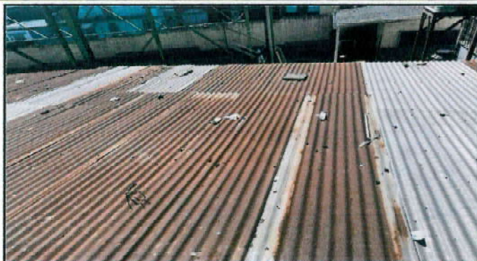
Desinstalación e instalación de lamina troquelada calibre 26 troquelada aluzin en area de corredor.
