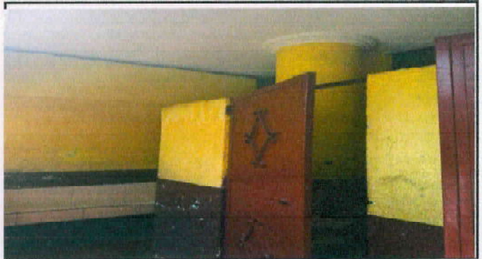
suministrar e instalar azulejo en baños niños y niñas pegado con psp
