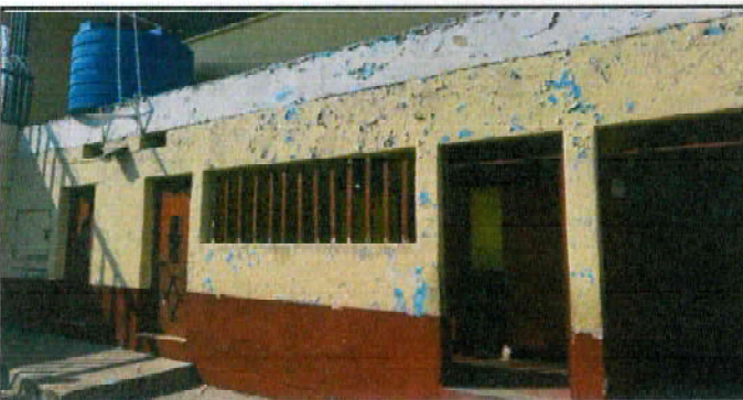
pintura en muros exterior de baños (y cer salitre)
