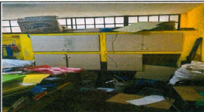
Instalación de azulejo en interior de gabinetes
