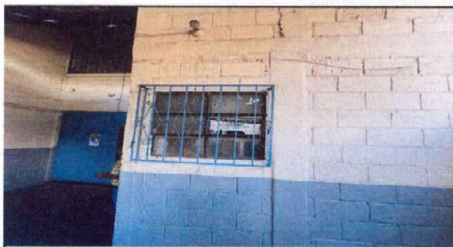
SUSTITUCIÓN DE PLAFONERA Y BOMBILLA DE ALTA DENSIDAD EN ENTRADA DE ESCUELA INCLUYE CABLEADO Y APAGADOR
