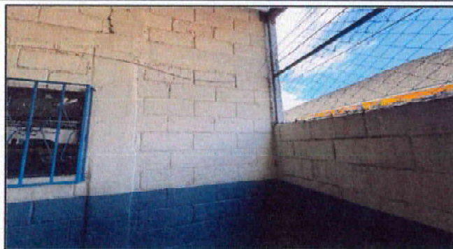
SUMINISTRO E INSTALACION DE BALCON EN AREA DE COCINA
