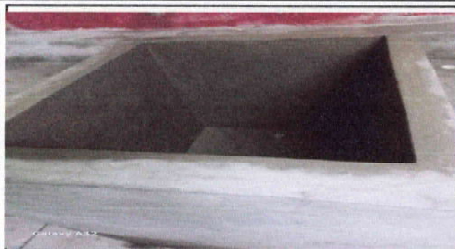
INSTALACION DE AZULEJO EN PILA EN COCINA DE ESCUELA
