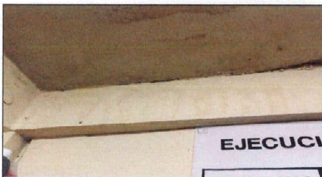
APLICACIÓN DE PINTURA EN AREA DE COCINA, EN SANITARIO DE MAESTROS Y DIRECCION
