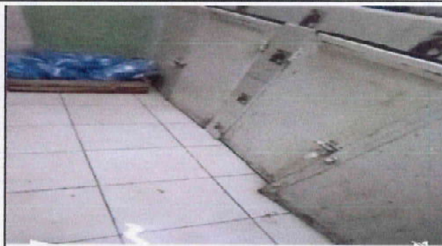
INSTALACION DE AZULEJO EN GABINETE DE COCINA
