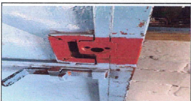
SUMINISTRO E INSTALACIÓN DE CHAPA YALE (desinstalar e instalar)
