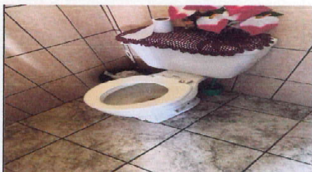
SUSTITUCION DE SERVIVIO SANITARIO DE MAESTROS DE PUSH
