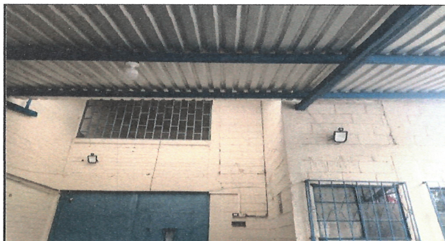
Aplicación de pintura latex acrílica color azul y blanco de agua en garage de escuela primer nivel y segundo nivel
