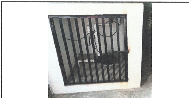
Sustitución de caceta de caseta para instalar bomba e hidroneumatico, ( romper concreto para poder llevar la tubería de ingreso y salida de agua y reparar nuevamente). Instalación de sistema de bombeo y accesorios
