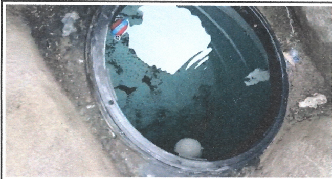
Sustitución de tinaco de 2,500 litros para Cisterna
