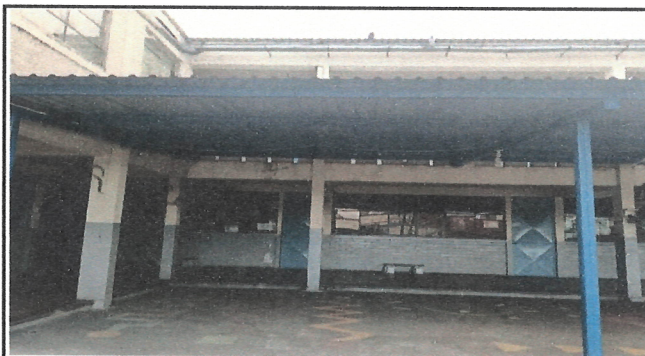
Suministro e instalación de canal de lamina de aluzin calibre 26 el canal se fabricaría para que sea reforzado (incluye pescantes, sellos)
