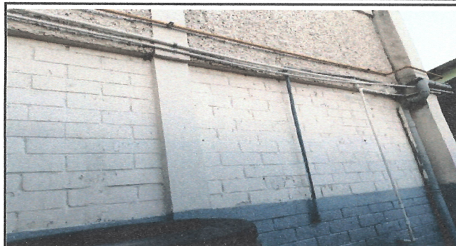
Sustitución de tubería existente que ya no funciona en toda la escuela e instalación de tubería nueva sobre puesta de 3/4" y reducida a 1/2" para los servicios que fueran necesarios en primer y segundo nivel, incluyendo los tinacos y sisternas.
