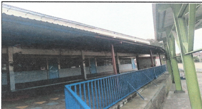
Suministro e instalación de canal de lámina de aluzinc calibre 26 (incluye pescantes, sellos)
