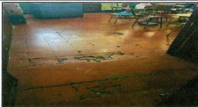
instalación de piso ceramico en 3 aulas y corredor en 2do nivel pegado con psp
