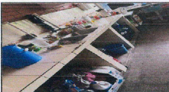
fundición de plancha de concreto, con lavabastos de 2 fosas, grifería, instalación de drenaje, agua potable, igual al la de foto en formato de fotos(3.33x0.60)
