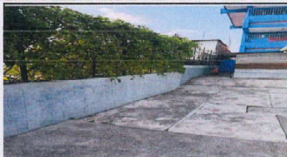
desinstalación de malla existente en pared a continuar
