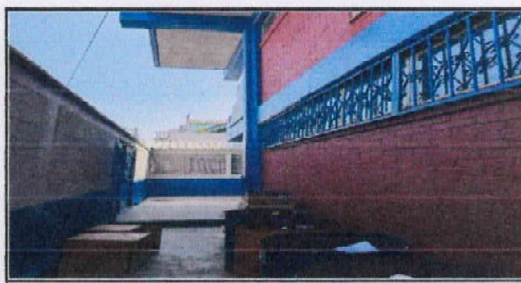
suministro e instalación de lamina troquelada de aluzin calibre 26 incluye estructura metálica, canal y bajada de agua
