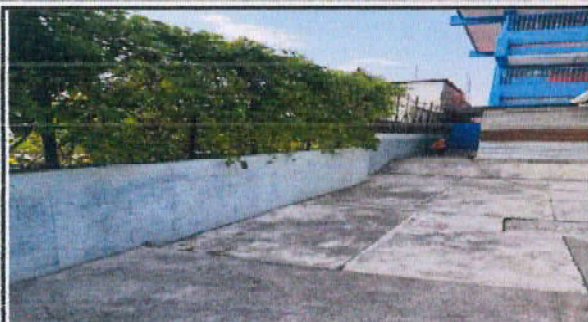
reparación y ampliación de altura de muro perimetral en escuela columnas con hierro de 3/8 y soleros, ciclado
