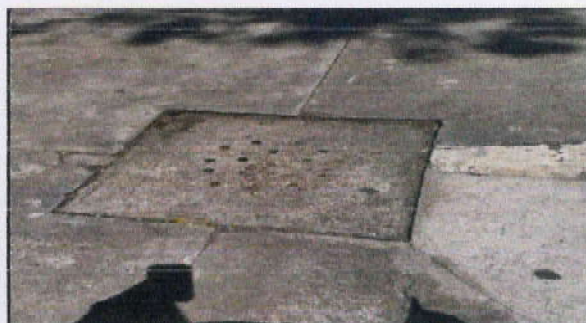
suministrar rejilla para repostería donde se va fundir plancha nueva primer nivel
