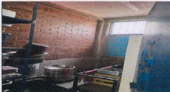
suministro e instalación de campa para cocina de lamina de aluzin (1.17x0.85)
