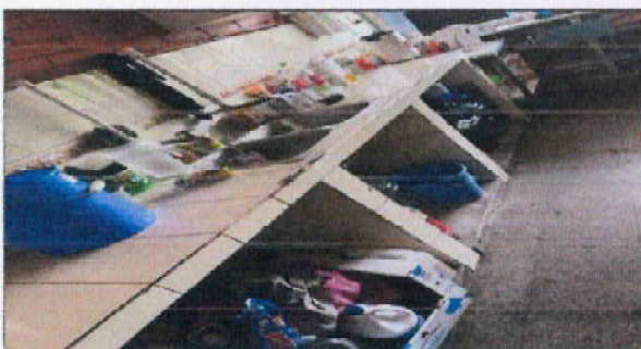
suministro e instalación de azulejo en cocina en 2 niveles, incluye plancha de concreto
