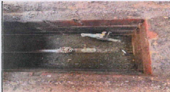
colocar baypas en tubería para sistema, cambio de cheque, cambio de llave de esfera 3/4 y agrandar caja de registro y fabricar tapador, para realizar el trabajo
