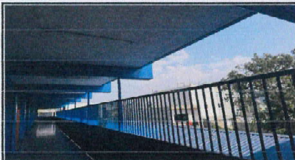
suministro e instalación de estructura metálica en pasillo de 3er nivel de escuela por ingreso de agua de lluvia (1.83 de largo con tubo de 1 1/4 y lamina de aluzin troquelada calibre 26 y tornillería de sujeción )
