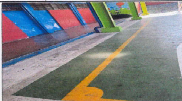
suministrar e instalar rejillas en cuneta de concreto en domo de escuela
