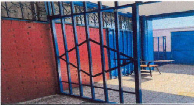
reparación y mantenimiento a puerta de rejas de ingreso de escuela
