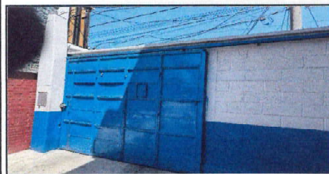
Mantenimiento y reparación de portón de ingreso de vehículos (cambio de rieles, chapa, cambio de lamina podrida en diferentes secciones, lijado y pintura)
