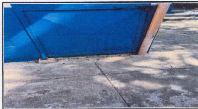
reparación de puerta en aula de primer nivel en aula frente a lavamanos
