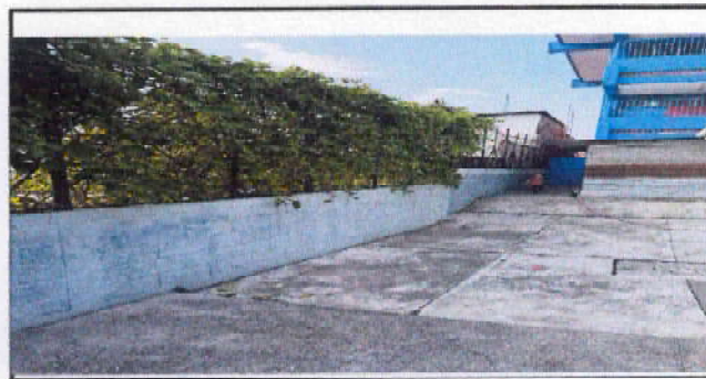
revisión y reparación en hundimiento en la parte de atrás de la escuela
