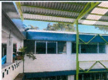
Foto 2: Suministro e instalación de 2 balcones en aula de computación, similares a los del primer nivel
