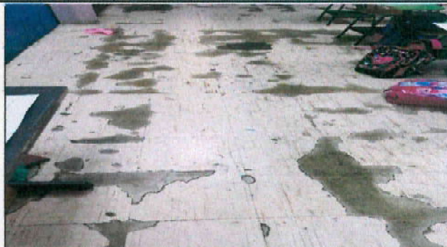
SUMINISTRO E INSTALACION DE PISO EN AULAS DE SEGUNDO NIVEL, LIMPIEZA DE AREA EXISTENTE INSTALACION CON PSP
