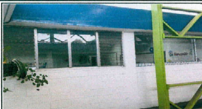
SUMINISTRO E INSTALACION DE BALCONES EN SALON DE COMPUTACIÓN
