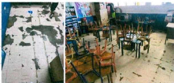
Foto1: Remozamiento de piso dañado en aula 5 años, aula de computación, primero A, aula de 4 años, Aula Recurso; se instalará piso de formato 0.43x0.43 el más parecido al de otras áreas.
