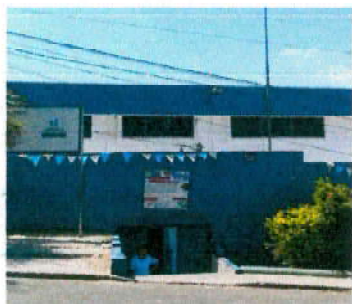
Foto 5: Suministro e instalación de reja metálica tipo puerta, de dos hojas para el área de ingreso principal, incluye chapa con llave. (medida 2.05x2.10)
