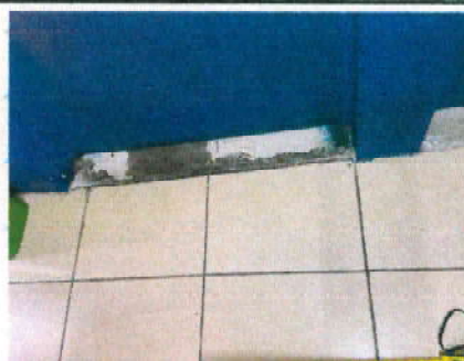
Foto 6: Remozamiento de marco y puerta de aulas en donde se instalará piso para que pueda abatirse con el piso nuevo ya instalado. (Incluye desinstalación e instalación)
