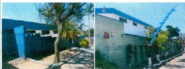
Foto 3: Suministro e instalación de razor ribbon galvanizado + bases para instalación. Instalación en muro perimetral parte frontal y lateral de la Escuela.
