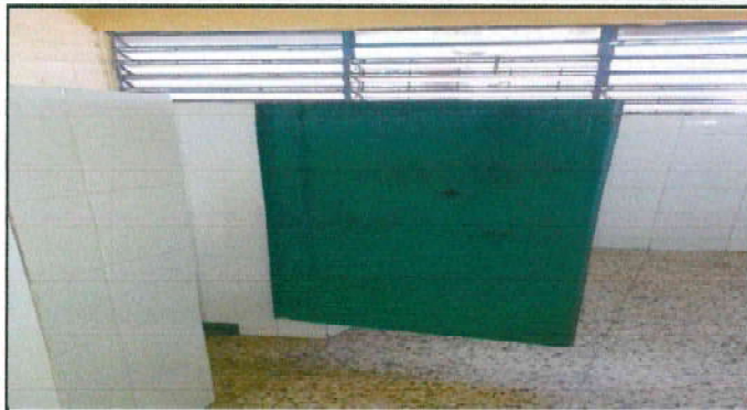
fabricación de puertas para sanitarios 2 unidades
