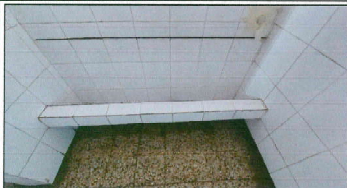
aplicación de plancha de concreto en area donde se va demoler urinal y se va a instar sanitarios nuevos ( se necesita instalar tubería de drenaje y agua potable)
