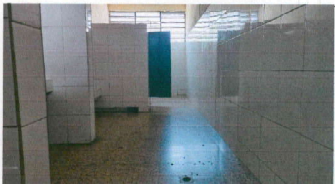
Suministro e instalación de azulejo en sanitarios
