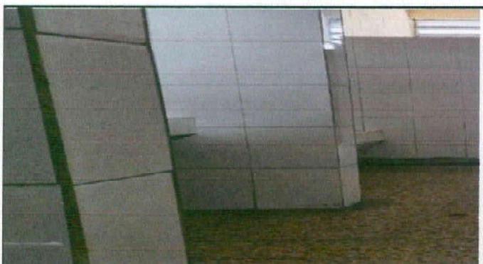
aplicación de plancha de concreto en area donde se va demoler urinal y se va a instar sanitarios nuevos ( se necesita instalar tubería de drenaje y agua potable)
