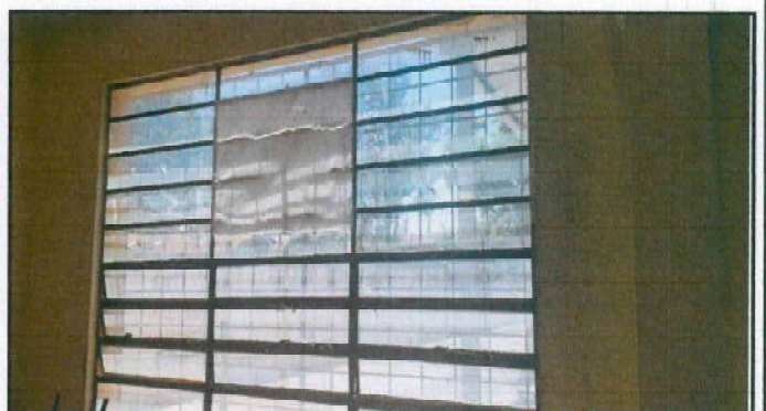
suministrar e instalar balcones en area de computación y direccion JM (1.83 x 2.72) 4 unidades incluye
