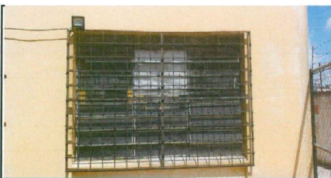
Sustitución de ventanas por ventanas de metal corredizas en salon de computación y direccion JM 2.60 X 1.71 incluye vidrios
