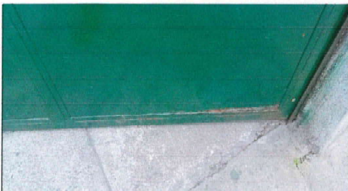
reparación de porton del lado de la cancha deportiva
