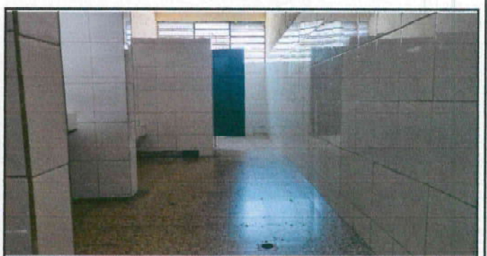
Suministro e instalación de piso ceramico anti deslizante en sanitarios
