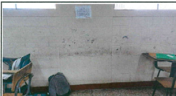
Suministro y aplicación de pintura para interior de aulas de agua 100% lavable, zocalo con pintura crítica y aplicación de zero salitre en áreas afectadas por cal
