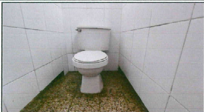
suministrar sanitarios e instalacion con accesorios contra llave y manguera de abasto
