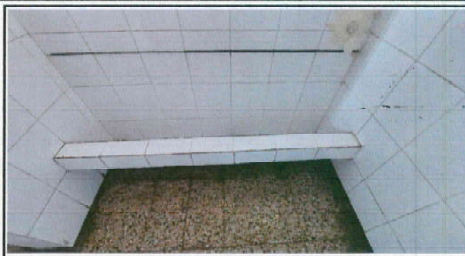
demolision de urinal existente en escuela e instalar sanitario en el área
