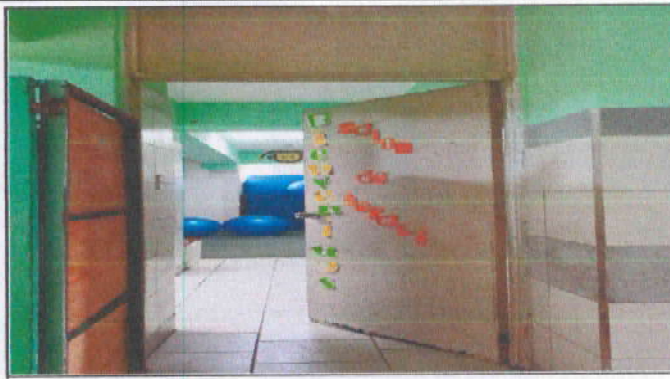
Suministrar e instalar puerta de rejas en salon de motricidad con medidas de ( 2.69 x 0.88) con tubo de 1 x 1 chapa 18 con 2 pasadores
