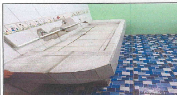
cambio de azulejo en 6 modulos de lavamanos ( desinstalación de azulejo existente e instalacion de azulejo nuevo ), incluye reparación de drenaje y cambio de reposaderas de los mismos
