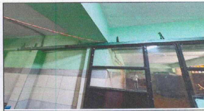
mantenimiento a porton de 1er nivel, revision de guia, colocación de pasador y lijado y aplicación pintura anticorrosiva general con medidas de seguridad. Incluye sustitución de chapa
