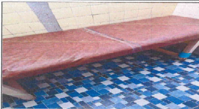
sustitucion de plancha metalica a de planchas de concreto para cambiadores en centro educativo con medidas ( largo 1.85 mts. ancho 0.60 mts. alto 0.70 mts, 10 cm grosor
