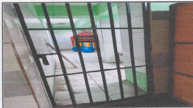
Sustitución de piso en area de motricidad por piso cerámico
