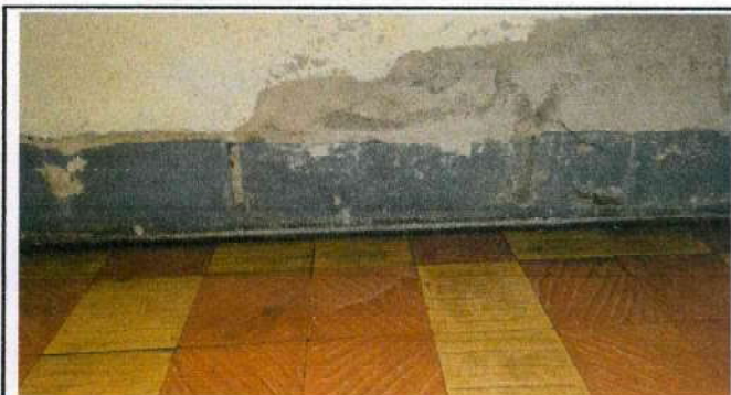
quitar cernido en mal estado y aplicación de cernido nuevo en area de Laboratorios de Biología, Química y Cinencias Naturales, interior e exterior y primer nivel en area de salones
