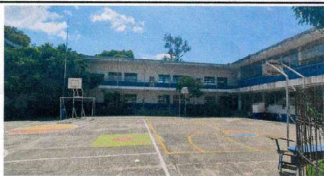
aplicación de pintura en toda las parte exterior de 1ro y 2do nivel area de hogar Aplicación de pintura 100% labable y 100% anti hongo
