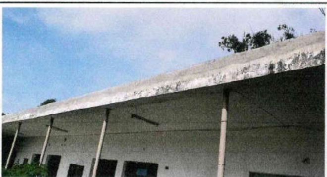
aplicación de sika zero salitre de alta calidad para exterior, aplicación en cenefas y parte de paredes que tiene cal
