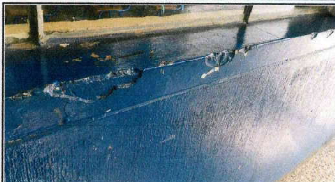
aplicación de esmalte acrílico de secado rapido a aplicarse en area de zocalo color azul
