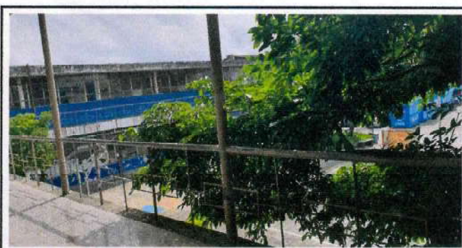
manteminiento de baranda de segundo nivel
