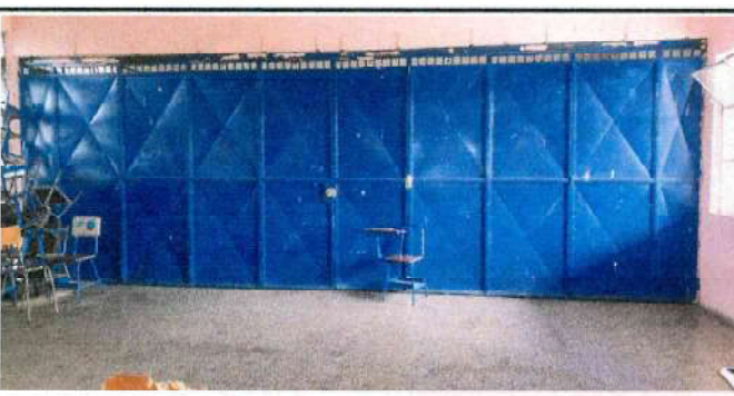
reparación de porton de 10 secciones corredizo en salon de primer nivel incluye pintura
