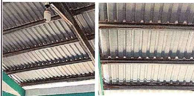
Foto 2: ESTRUCTURA DE TECHO. 2.1 Mantenimiento a estructura soporte metal. 2.3 Sustitución de estructura de soporte de metal, por metal
