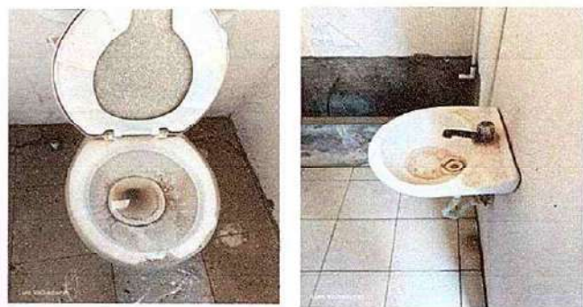
Foto 4: 10. SERVICIOS SANITARIOS Y SUS ACCESORIOS. 10. 3 Sustitución de inodoro. 10.5 Sustitución de lavamanos.
