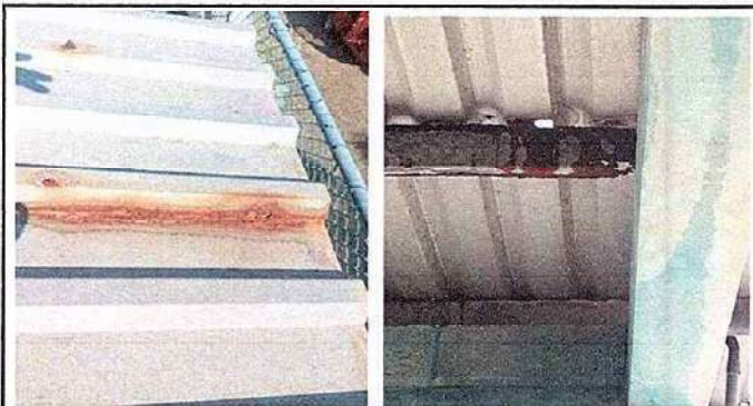
Foto 1: 1 CUBIERTA DE LAMINA. 1.1 Sustitución de lámina, por lámina troquelada aluzinc calibre 26. 1.2 Sustitución de capote de lámina, para lamina troquelada. 1.3 Sustitución de elementos de fijación.
