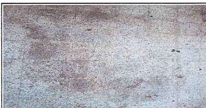
Foto 5: 6.10 Sustitución de piso de concreto por piso cerámico
