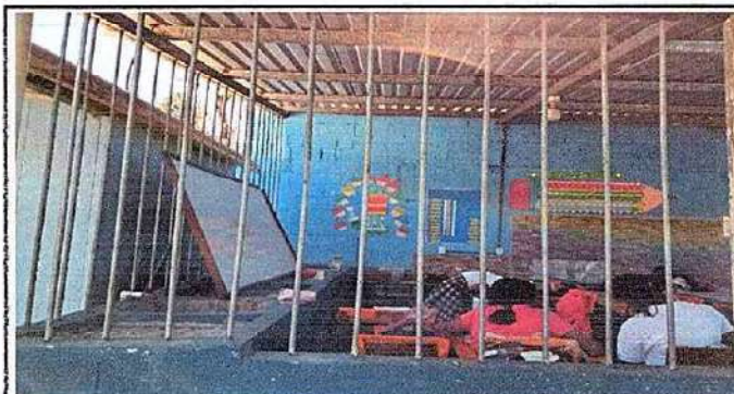
Foto 4: 5.7 Mantenimiento a balcones de metal
