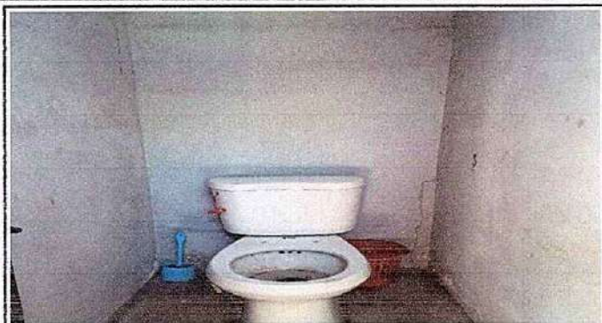
Foto 7: 13.1 Sustitución de azulejo
