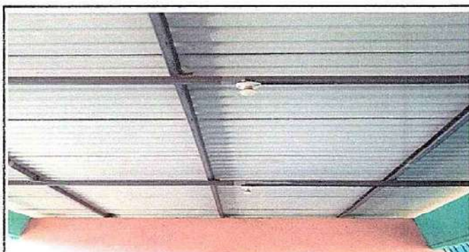
Foto 9: 17.4 Sustitución de focos ahorradores. 17.5 Sustitución de plafoneras
