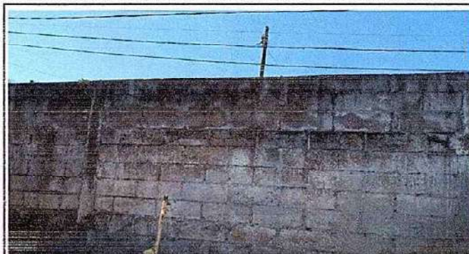
Foto 8: 15.1 Reparación de muro perimetral de block.
