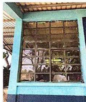
Foto 4: 5.2 Sustitución de estructura de metal de ventana
