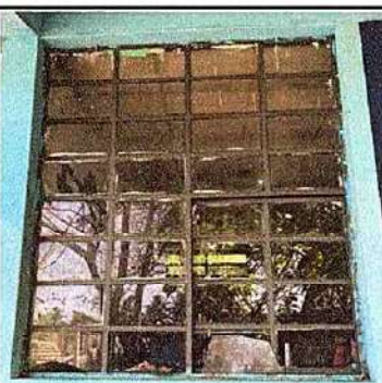
Foto 5: 5.5 Sustitución de vidrios
