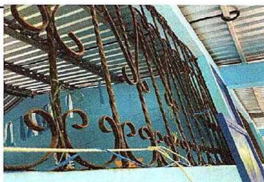
Foto 6: 5.7 Mantenimiento a balcones de metal
