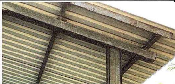
Foto 2: 2.1 Mantenimiento a estructura de soporte de metal
