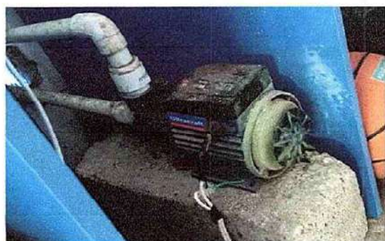
Foto 15: 18.7 Sustitución de bomba de agua, incluyendo mesita de soporte
