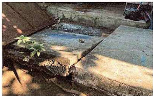
Foto 7: 8.2 Reparación de banquetas de concreto
