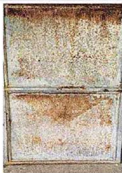
Foto 3: 4.3 Sustitución de puerta
