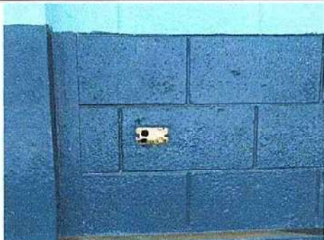
Foto 13: 17.8 Sustitución de tomacorrientes dobles
