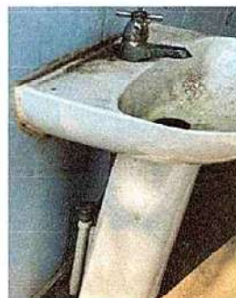
Foto 10: 14.13 Sustitución de llave de chorro
