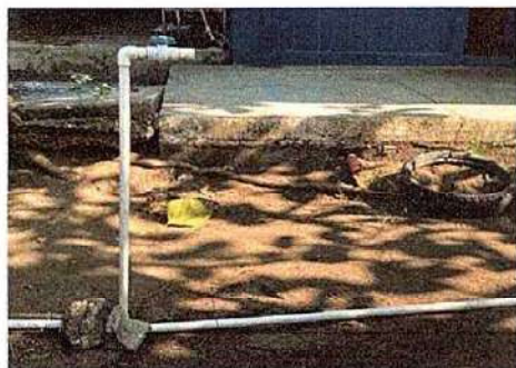
Foto 9: 14.9 Instalación de tubería principal de pvc
