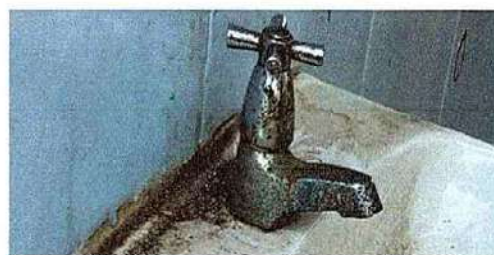
Foto 16: 19.3 Instalación de chorros
