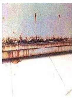
Foto 4: Puertas de metal. 4.1 Matenimiento de estructura (lijado, cambio de tubo, sepillado, sujeciones, aplicación de pintura) 4.3 Sustitución de puerta.
