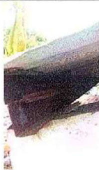
Foto1: Cubierta de lamina 1.1 Sustitución de lamina por lamina troquelada aluzin calibre 26, 1.2 Sustitución de capote de lamina por lamina troquelada. 1.3 Sustitución de elementos de fijación.
