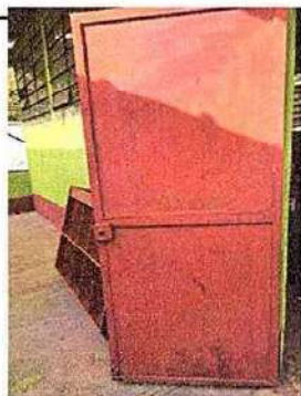
Foto 4: Puertas de metal. 4.1 Matenimiento de estructura (lijado, cambio de tubo, sepillado, sujeciones, aplicación de pintura) 4.3 Sustitución de puerta.
