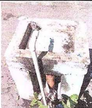
19.17 Instalación de lavamanos.
