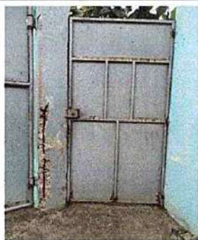
4 PUERTAS DE METAL 4.1 MANTENIMIENTO A ESTRUCTURA (LIJADO, CAMBIO DE TUBO, CEPILLADO, SUJECIONES, APLICACIÓN DE PINTURA) 4.3 SUSTITUCIÓN DE PUERTA
