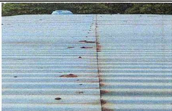
1 CUBIERTA DE LAMINA 1.1 SUSTITUCION DE LAMINA, POR LÁMINA TROQUELADA ALUZINC CALIBRE 26
