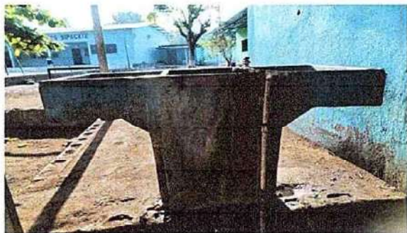
19.20 INSTALACIÓN DE PILA
