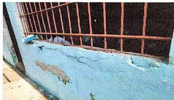
21 REPARACIÓN DE REPELLO Y CERNIDO DE PAREDES (CUANDO APLIQUE) 21.1 REPELLO DE MURO 21.4 SELLADO DE GRIETAS Y FISURAS EN MUROS
