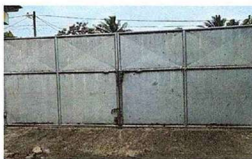
12 MANTENIMIENTO A PORTONES 12.1 MANTENIMIENTO A PORTONES DE METAL
