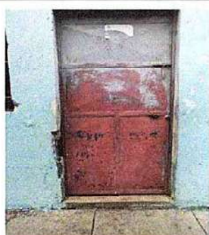
4 PUERTAS DE METAL 4.1 MANTENIMIENTO A ESTRUCTURA (LIJADO, CAMBIO DE TUBO, CEPILLADO, SUJECIONES, APLICACIÓN DE PINTURA) 4.3 SUSTITUCIÓN DE PUERTA
