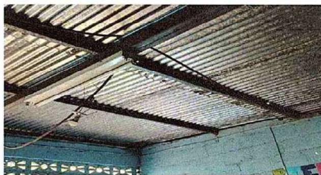
2 ESTRUCTURA DE TECHO 2.3 SUSTITUCIÓN DE ESTRUCTURA DE METAL, POR METAL
