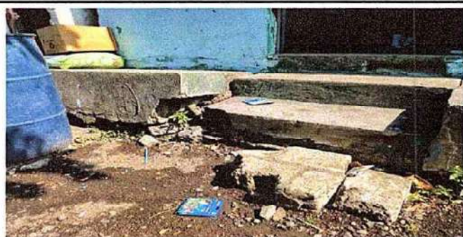
8 CUNETA DE CONCRETO 8.2 REPARACIÓN DE BANQUETAS DE CONCRETO
