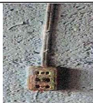
17.8 SUSTITUCIÓN DE TOMACORRIENTES DOBLES 17.11 REPARACIÓN DEL CABLEADO ELECTRICO
