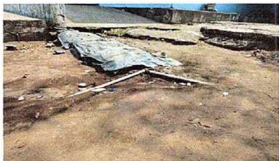
14 REPARACIÓN DE RED DE DRENAJE Y AGUA POTABLE AGUA POTABLE 14.9 SUSTITUCIÓN DE TUBERÍA LÍNEA PRINCIPAL
