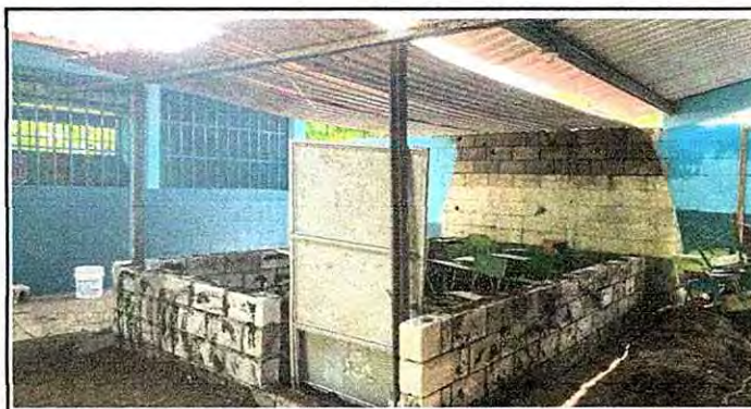
Foto 4: 9.1 Pintura en muro exteriores e interiores
