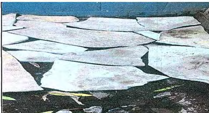
Foto 3: 6.6 Sustitucion de piso de cemento liquido
