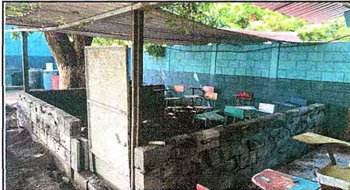
Foto 2: 2.3 Sustitucion de estructura de soporte de metal por metal.
