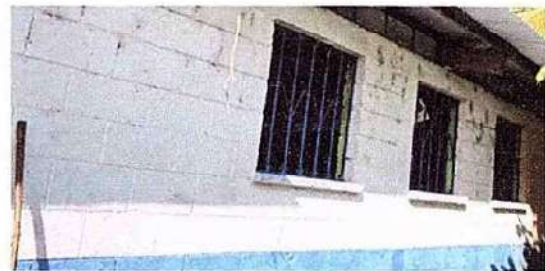
Foto 4: 5 VENTANAS 5.7 Mantenimiento de balcones de metal
