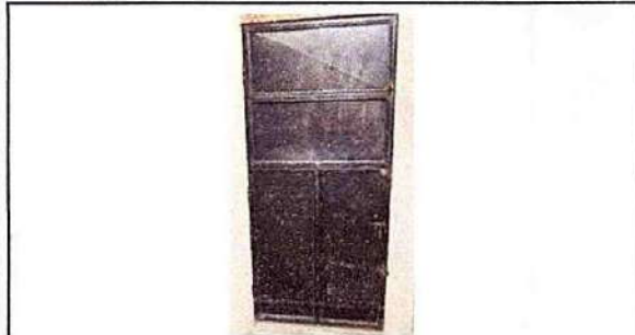
Foto 1: 4 PUERTAS DE METAL 4.1 Mantenimiento a estructura (lijado, cambio de tubo, cepillado, sujeciones, aplicación de pintura)
