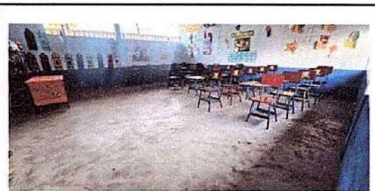
Foto 6: 6 PISO 6.11 Sustitución de piso de cemento por piso cerámico
