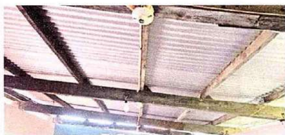
Foto 7: 17 REPARACIÓN DE SISTEMA ELÉCTRICO 17.1 Sustitución de focos ahorradores 17.4 Sustitución de plafoneras
