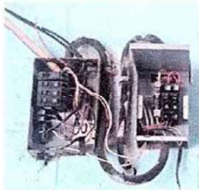
Foto 8: 17 REPARACIÓN DE SISTEMA ELÉCTRICO 17.9 Sustitución de flípones 17.10 Sustitución de tablero de flípones
