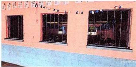
Foto 3: 5 VENTANAS 5.7 Mantenimiento de balcones de metal
