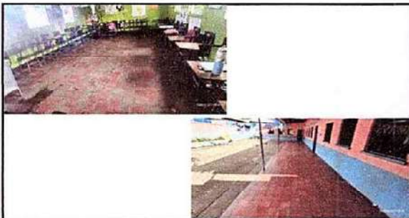
Foto 5: 6 PISO 6.11 Sustitución de piso de cemento por piso cerámico
