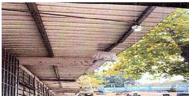
Foto 5: 17.4 Sustitución de focos ahorradores. 17.5 Sustitución de plafoneras.
