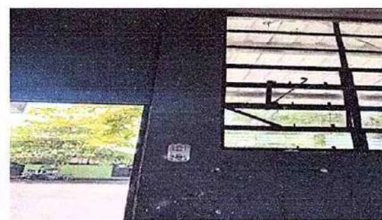
Foto 6: 17.6 Sustitución interruptores simples
