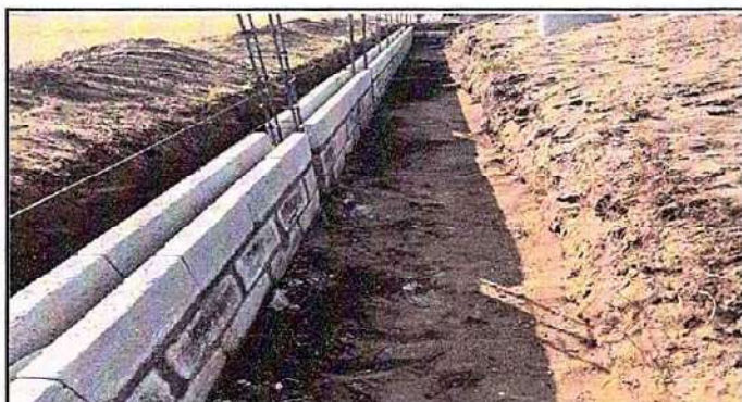
Foto 3: 15.2 Reparación de muro perimetral de block con tubo HG y malla galvanizada, soleras intermedias y columna.
