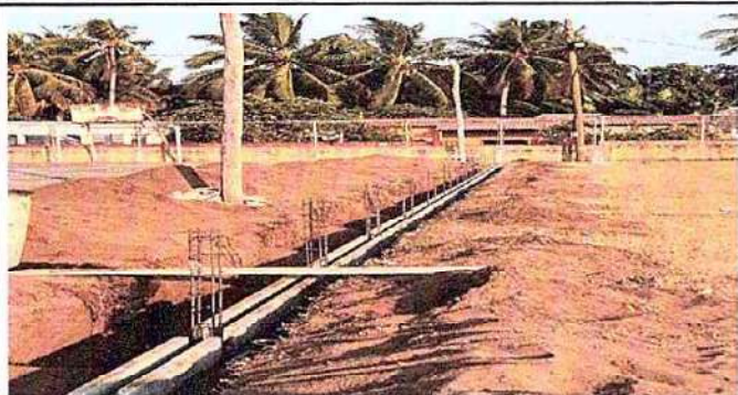
Foto 1: 15.2 Reparación de muro perimetral de Block con tubo HG y malla galvanizada, soleras intermedias y columnas mano de obra.
