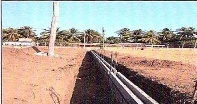
Foto 2: 15.2 Reparación de muro perimetral de Block con tubo HG y malla galvanizada, soleras intermedias y columnas mano de obra.
