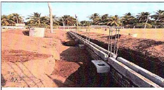
Foto 4: 15.2 Reparación de muro perimetral de block con tubo HG y malla galvanizada, soleras intermedias y columna.
