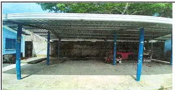
9.1: Pintura de muros exteriores
