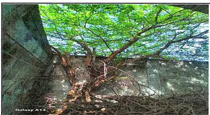
9.1: Pintura de muros exteriores
