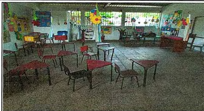
6.8: Sustitucion de piso ceramico de aula 2
