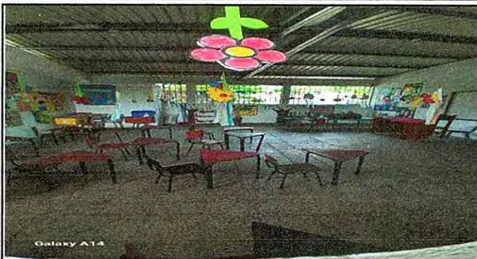
6.8: sustitucion de piso ceramico aula 1
