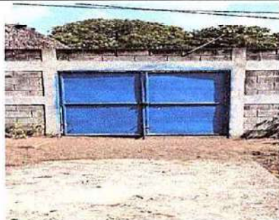
4.5 Sustitución de portón de metal
