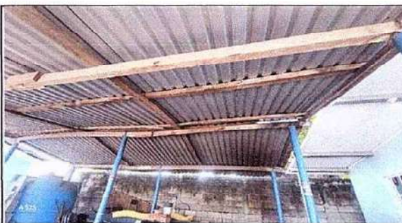
2.2 Sustitución de estructura de soporte de madera por metal
