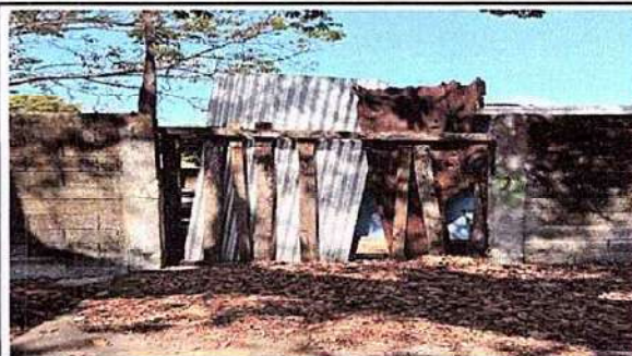
4.5 Sustitución de Pórtón de metal
