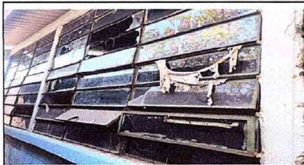
5.2 Sustitución de estructura de metal de ventanas por pvc
