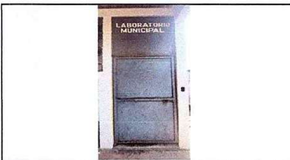
4.3 Sustitución de puerta
