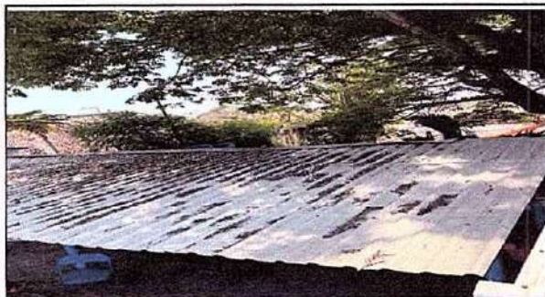
1.1 Cubierta de lámina, estructura de techo.
