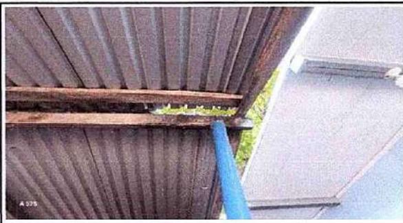
1.2 Sustitución de capote de lámina para lámina troquelada
