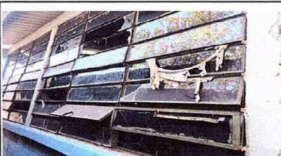
5.6 Sustitución de balcones de metal
