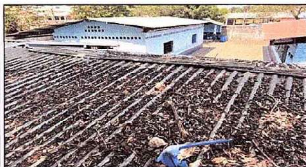
1.3 Sustitución de elementos de fijación
