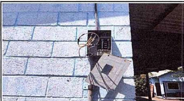
17.10 Sustitución de tablero de filpones
