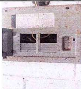
17.10 Sustitución de tablero de flípones
