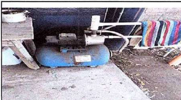
18.6 Reparación de bomba de agua
