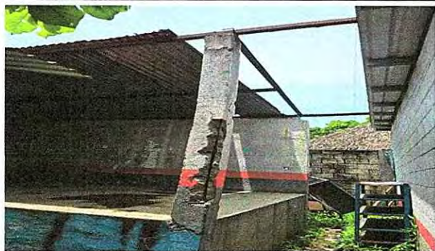
1 CUBIERTA DE LAMINA
