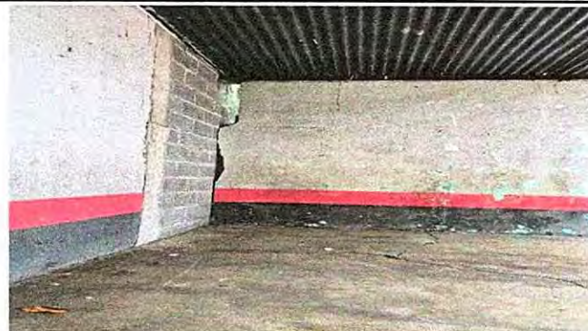
2. ESTRUCTURA DE TECHO
