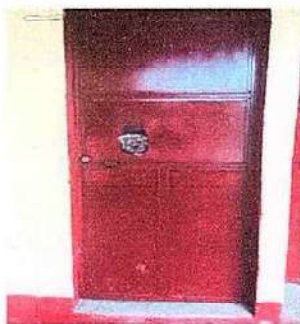
Foto 1: 4.3 SUSTITUCIÓN DE PUERTA (INCLUYE CHAPA)
