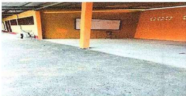
Foto 3: 6.8 SUSTITUCIÓN DE PISO CERÁMICO
