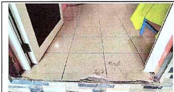
Foto 3: 6.8 Sustitución de piso cerámico
