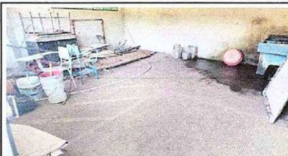
Foto 2: 6.5 Sustitución de piso de torta de concreto
