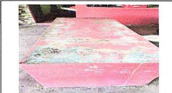
Foto 6: 20.8 Reparación de azulejo en muebles de cocina
