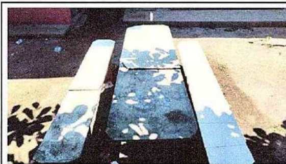
Foto 4: 13.1 Sustitución de azulejo
