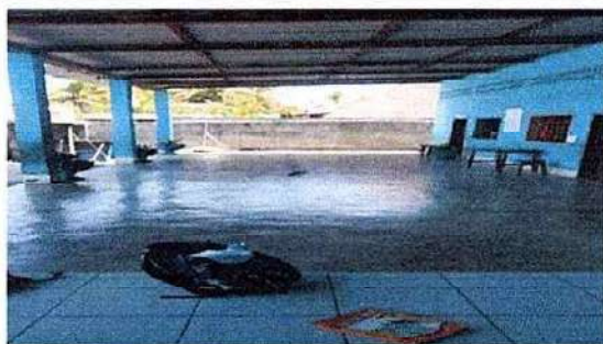
Foto 5: 6.8 Sustitución de piso cerámico
