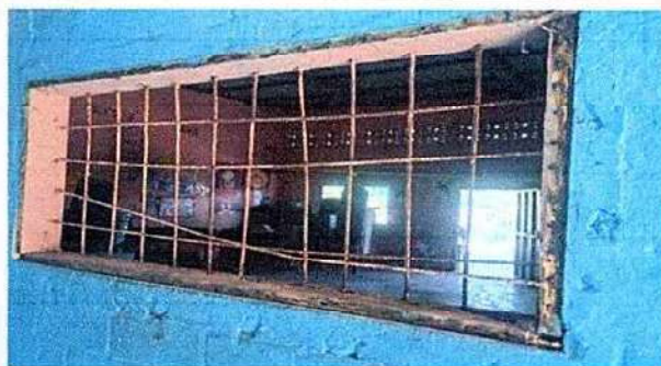
Foto 4: 5.6 Sustitución de balcones de metal
