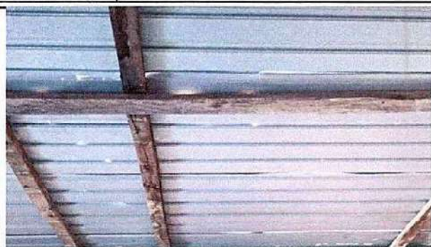
Foto 1: 1.1 Sustitución de lámina, por lamina troquelada aluzinc calibre 26
