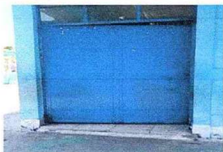
Foto 3: 4.3 Sustitución de puerta
