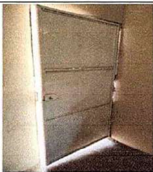
Foto 3: 4.3 SUSTITUCIÓN DE PUERTA
