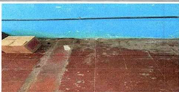
Foto 5: 6.4 REPARACIÓN DE PISO CERÁMICO
