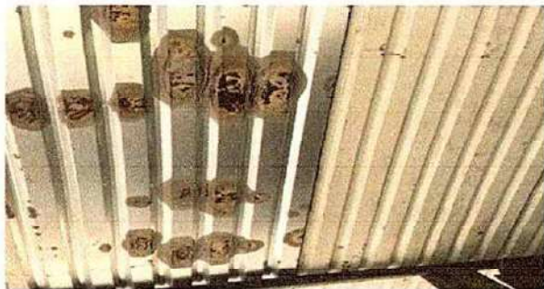
Foto1: 1.1 SUSTITUCIÓN DE LÁMINA, POR LÁMINA TROQUELADA ALUZIC CALIBRE 26
