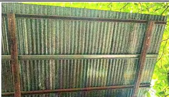
FOTO 1: 1.1 Sustitución de lámina, por lámina troquelada aluzinc calibre 26
