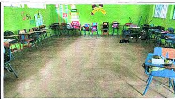
Foto 4: 6.11 Sustitución de piso de cemento por piso cerámico
