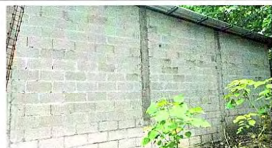
Foto 5: 21.1 Repello en muro
