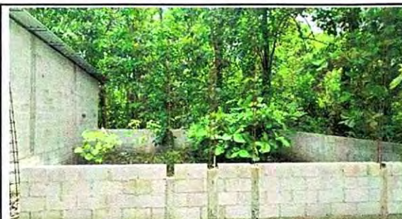
23.1 Reparación de muro de block en area de aula
