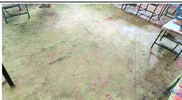
Foto 3: 6.5 Sustitución de torta de cemento
