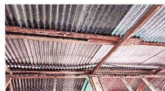
Foto 4: Renglon de trabajo 2.2 Sustitución de estructura de soporte de madera por metal.
