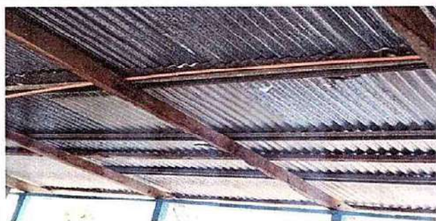
Foto 3: Renglon de trabajo 1.3 Sustitución de elementos de fijación.
