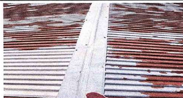
Foto 2: Renglon de trabajo 1.2 Sustitución de capote de lamina para lamina troquelada.
