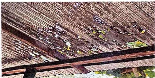
Foto1: Renglon de trabajo 1.1 Sustitución de lamina por lamina troquelada de aluzinc calibre 26
