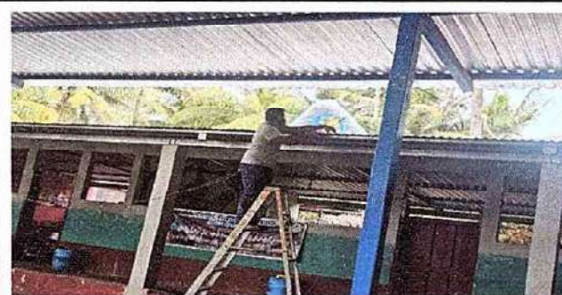
Foto 6: Renglon de trabajo 19.8 Instalación de lámina troquelada aluzinc.
