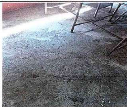
Foto 8: 6.5 Sustitución de piso de torta de concreto
