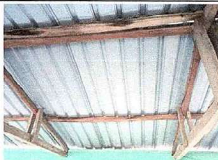
Foto 12: 19.7 Instalación de estructura portante de metal
