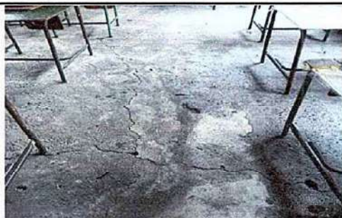
Foto 9: 6.6 Sustitución de piso de cemento líquido
