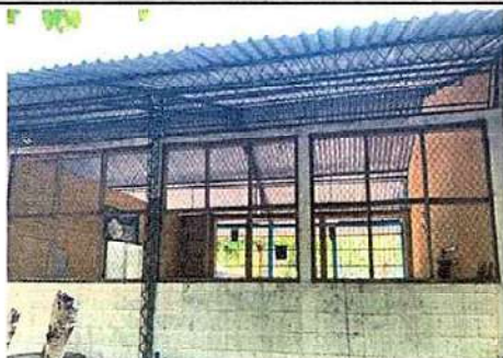
Foto 11: 19.2 Fabricación e instalación de balcones de hierro en ventana
