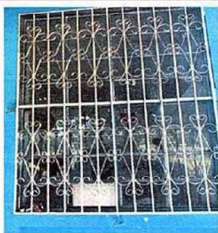
Foto 7: 5.7 Mantenimiento a balcones de metal
