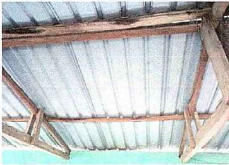
Foto 13: 19.8 Instalación de lámina troquelada aluzinc
