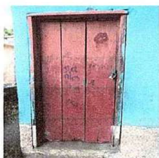
Foto 5: 4.3 Sustitucion de puerta
