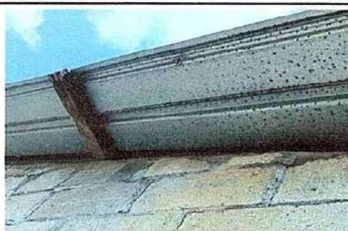
Foto 2: 1.3 Sustitución de elementos de fijacion
