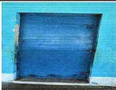
Foto 3: 4.3 Sustitución de puerta
