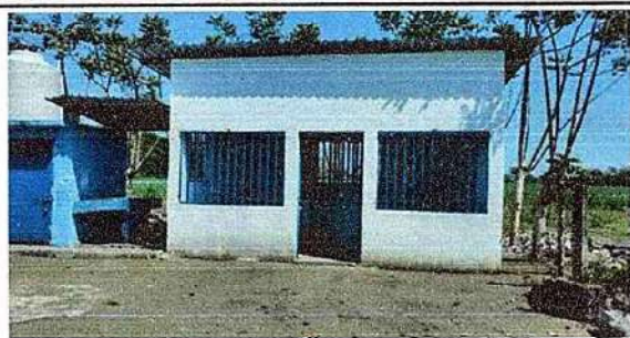
Foto 7: 9.1 Pintura en muros exteriores e interiores
