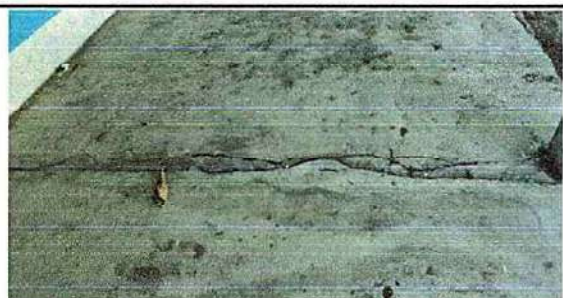
Foto 5: 6.5 Sustitución de piso de torta de concreto
