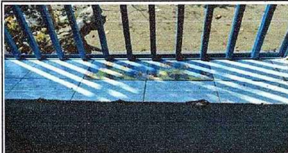
Foto 8: 13.1 Sustitución de azulejo
