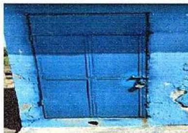
Foto 4: 4.4 Sustitución de puerta en servicios sanitarios
