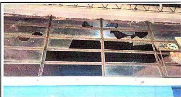
Foto 3: 5.2 Sustitución de estructura de metal de ventana
