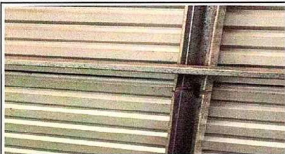
Foto 1: 2.1 Mantenimiento a estructura de soporte de metal
