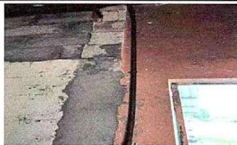
Foto 12: 17.12 Sustitución de ducto eléctrico + accesorios
