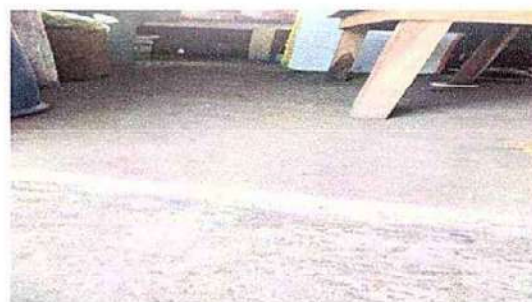
Foto 4: 6.5 Sustitución de piso de torta de concreto
