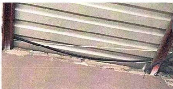
Foto 11: 17.11 Reparación de cableado eléctrico
