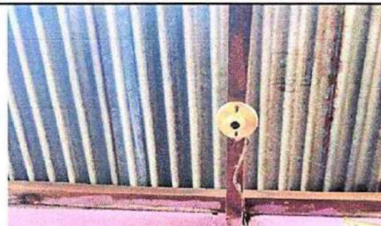
Foto 8: 17.5 Sustitución de plafonera
