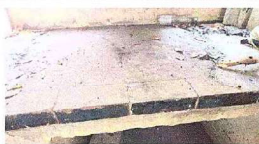
Foto 14: 20.8 Reparación de azulejo en muebles de cocina
