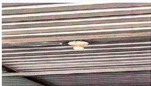
Foto 7: 17.3 Sustitución de lamparas tipo LED
