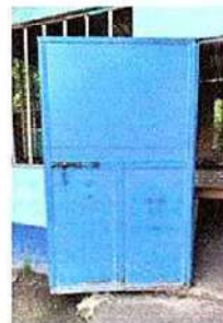
Foto 2: 4.3 Sustitución de puerta
