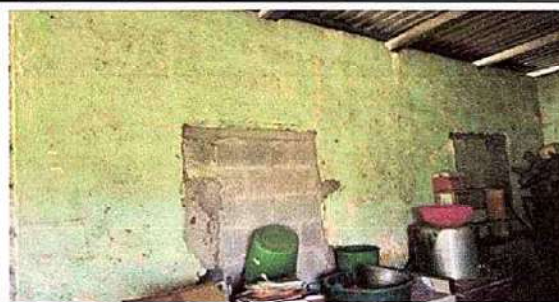
Foto 6: 9.1 Pintura en muros exteriores e interiores
