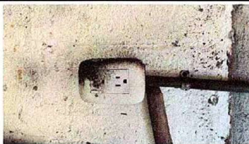
Foto 10: 17.8 Sustitución de tomacorrientes dobles
