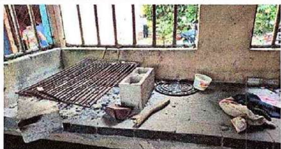
Foto 13: 20.2 Sustrucción de estufa rural (completa) incluye chimenea y plancha de metal
