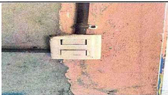
Foto 9: 17.7 Sustitución de interruptores dobles
