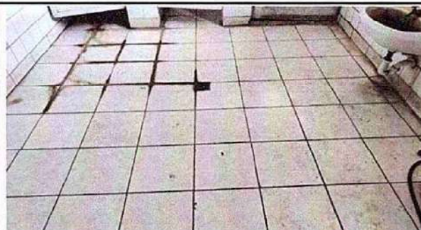
Foto 4: 6.8 Sustitución de piso cerámico
