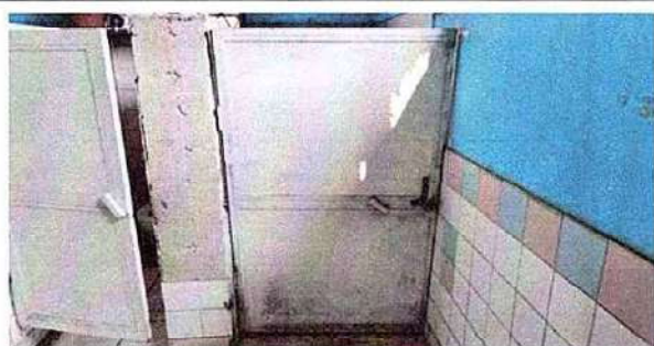
Foto 3: 4.4 Sustitución de puerta en servicios sanitarios
