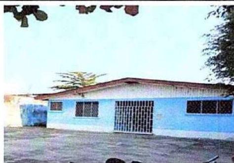
Foto 5: 9.1 Pintura en muros exteriores e interiores
