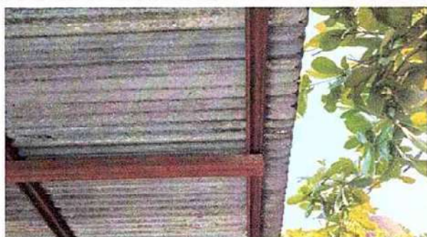
Foto 1: 1.1 Sustitución de lámina troquelada de aluzinc calibre 26
