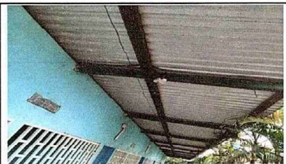
Foto 4: 2.3 Sustitución de estructura de soporte de metal, por metal
