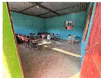
Foto 6: 6.4 Reparación de piso cerámico
