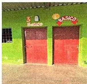
Foto 3: 4.1 mantenimiento a estructura (lijado, cambio de tubo, cepillado, sujeciones apliación de pintura)
