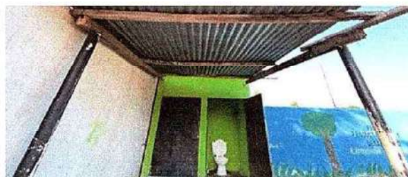
Foto 2: 2.2 Sustitución de estructura de soporte de madera, por metal
