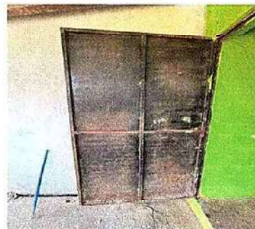
Foto 4: 4.3 Sustitución de puerta
