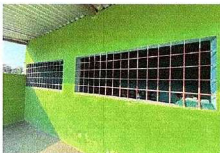
Foto 5: 5.6 Sustitución de balcones de metal
