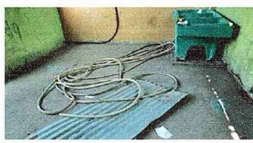
Foto 6: 6.8 Sustitución de piso cerámico
