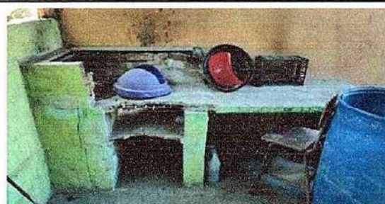
Foto 17: 20.2 Sustitución de estufa rural (completa) incluye chimeea y plancha de metal
