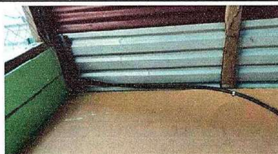
Foto 14: 17.12 Sustitución de ducto eléctrico + accesorios
