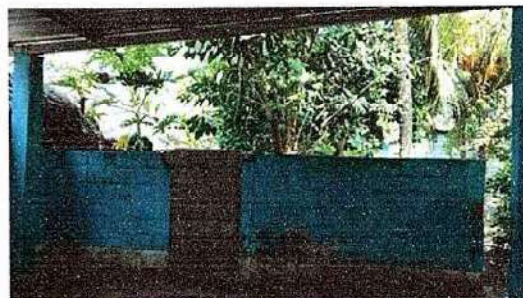
Foto 8: 15.1 Reparación de muro perimetral de block
