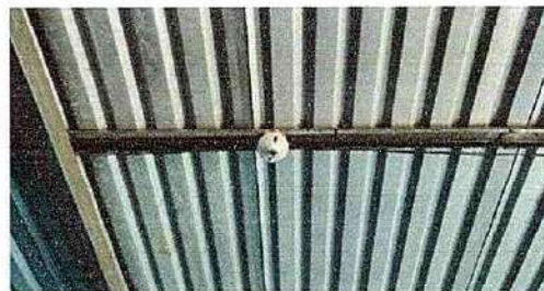
Foto 10: 17.5 Sustitución de plafonera
