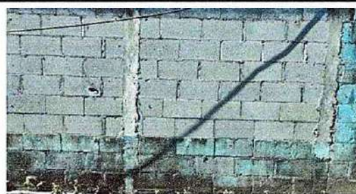
Foto 18: 21.1 Repello en muro
