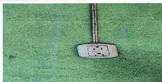
Foto 12: 17.8 Sustitución de tomacorrientes dobles
