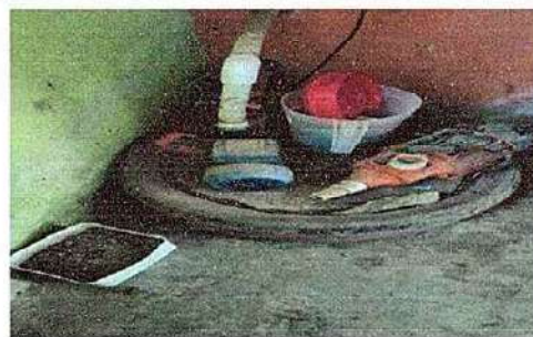
Foto 16: 18.7 Sustitución de bomba de agua
