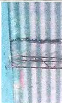
Foto1: 1.1. Sustitución de lámina por lámina troquelada aluzinc calibre 26
