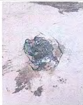
Foto 4: 6.1 Reparación de piso de torta de concreto.
