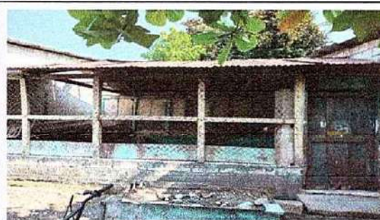
Foto 4: 5.2 Sustitución de estructura de metal de ventana
