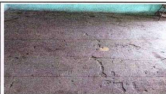
Foto 6: 6.5 Sustitución de piso de torta de concreto
