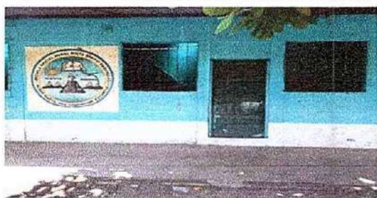
Foto 5: 9.1 Pintura en muros exteriores e interiores
