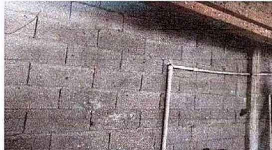
Foto 10: 21.1 Repello en muro
