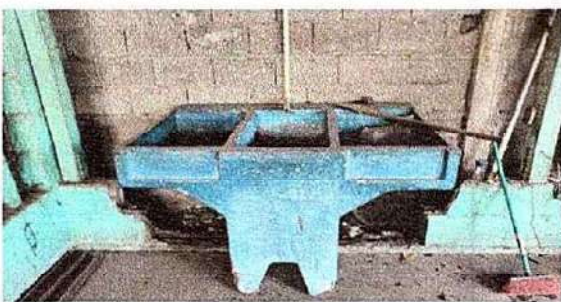
Foto 9: 20.10 Sustitución de pila de dos lavaderos
