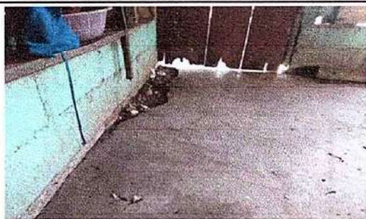
Foto 7: 6.8 Sustitución de piso cerámico
