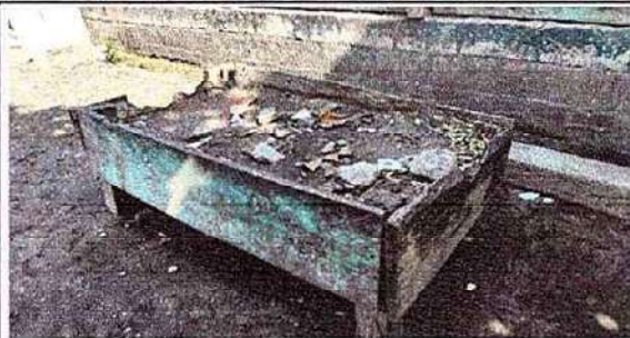
Foto 8: 20.2 Sustitución de estufa rural (completa) incluye chimenea y plancha de metal
